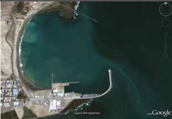
Imagen 21: Vista aérea con el puerto de Comodoro Rivadavia en el sector inferior y la Terminal Km 3 (Repsol YPF) en el sector superior
