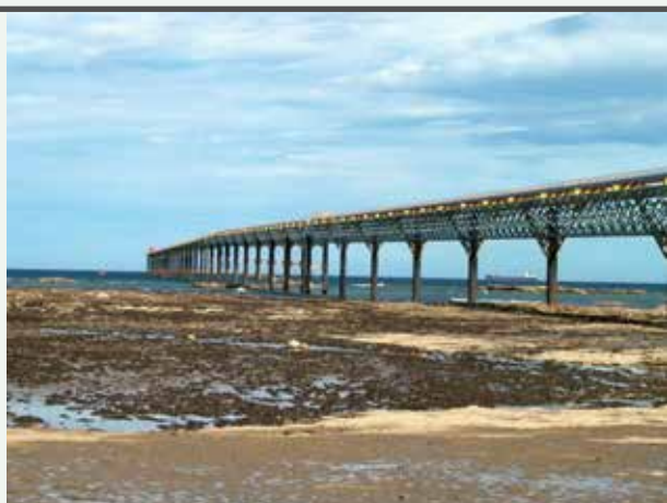
Imagen 18: Muelle General Mosconi en Km 3 (Repsol YPF)
