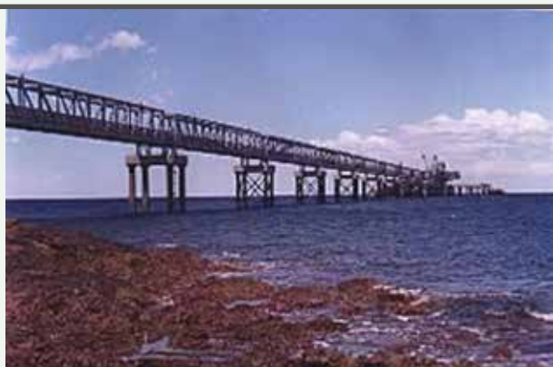
Imagen 11: Punta Colorada – Vista del viaducto y del frente de atraque desde la costa
