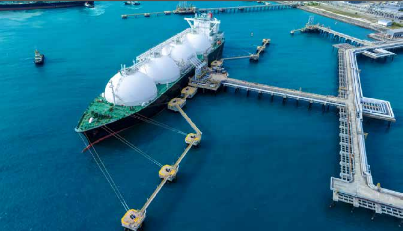
Figura 11: Muelle con tipología de estructuras independientes.
