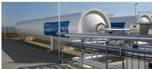
Figura 42: Sistemas de estocagem de LH<sub>2</sub> em tanques cilíndricos. Fonte: <https://www.linde-engineering.com/en/about-linde-engineering/success-stories/H2-mobility.html>
